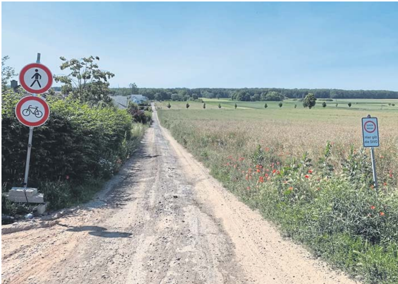
Die Baustraße im Neubaugebiet von Mittelbuchen. Nach Ansicht der IG Bauvorhaben ist und bleibt sie aufgrund der Anliegerbelastungen eine Fehlplanung.
