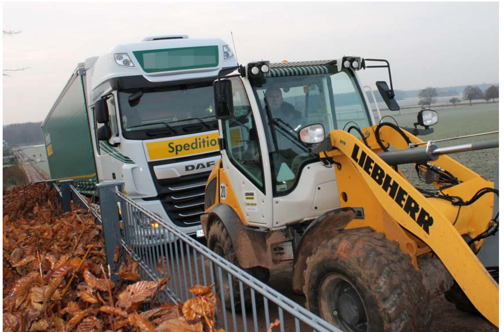
Letztlich hilft nur das Abschleppen: Ein Bagger muss den steckengebliebenen Lkw hinauf zur Baustelle ziehen.
