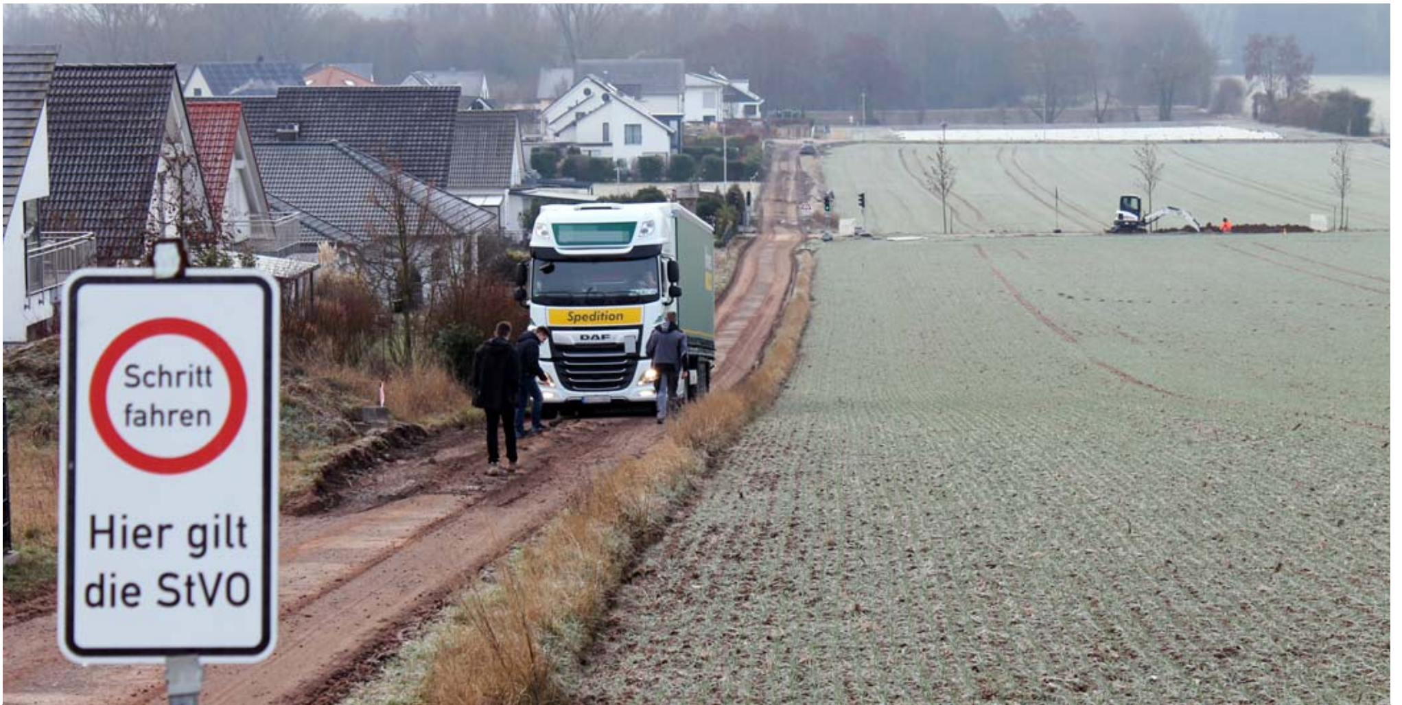
Auf der Baustraße zum Neubaugebiet am nordwestlichen Rand von Mittelbuchen müssen Fahrzeuge Schritt fahren. Allerdings kommen manche von ihnen aufgrund der Steigung und schlechten Befestigung der Straße im Schrittempo nicht den Berg hoch und bleiben, so wie dieser Lkw, hängen.
